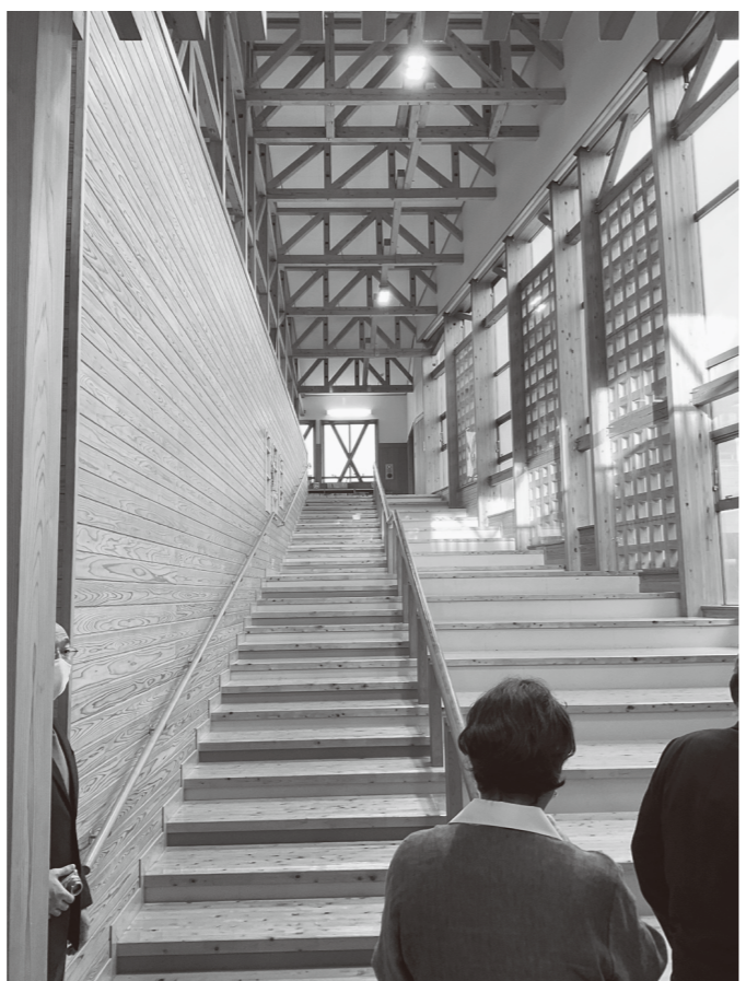
ベンチにもなる栗野小学校の多目的階段
